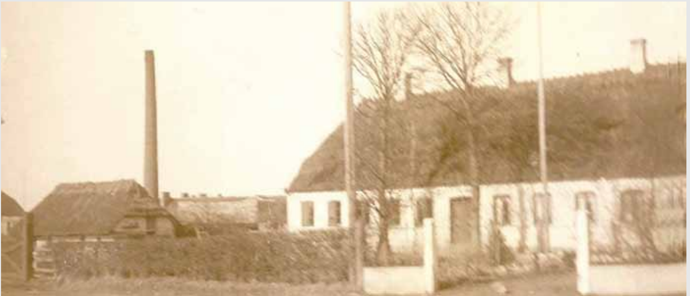
B549 Foto fra 1930 Svendborgvej 405 Stuehus og udhus af Munkegården Ladebygningerne udflyttet til Munkegårdsvej 4
